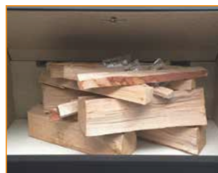
Optændingsposer placeres mellem de øverste pinde
